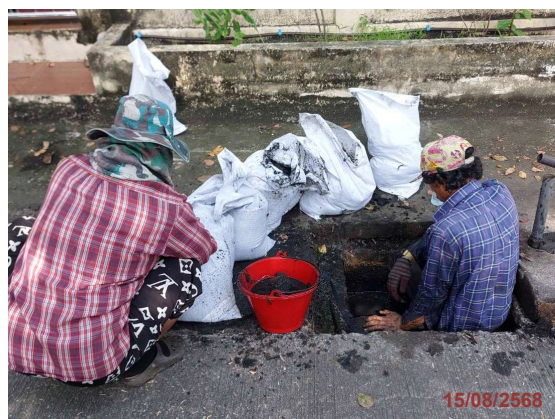
ภาพถ่ายที่ 2-2 การสูบน้ำและลอกท่อระบายน้ำในโครงการ
